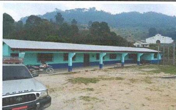
Foto 4: Canales y bajadas de agua pluvial
