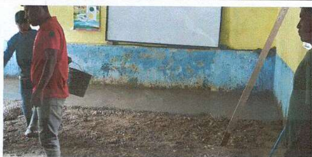
Foto 3: Reparacion de piso
