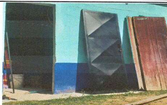
Foto 2: Puerta de baño
