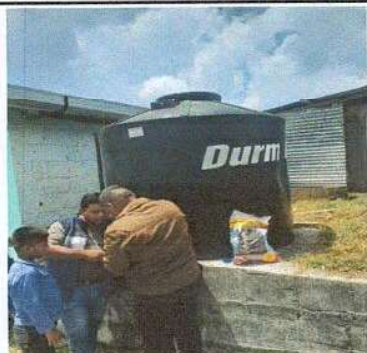
Foto 9: Reparacion y mantenimiento de deposito de agua
