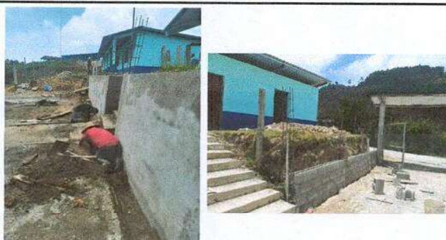
Foto 5: Cuneta de concreto y muro de contension
