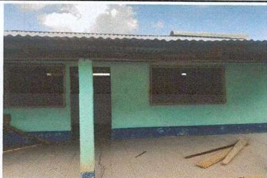
Foto 1: Cambio de ventana de cocina
